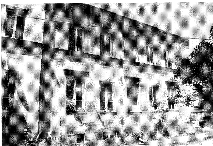
1. BUDYNEK MIESZKALNY, UL. WOLSKA 7, LUBLIN WIDOK OGÓLNY ELEWACJI. WIDOCZNE USZKODZENIA, ZAWILGOCENIA, SPĘKANIA, DESTRUKCJA MURU I TYNKU. STAN ISTNIEJĄCY LIPIEC 2015.
