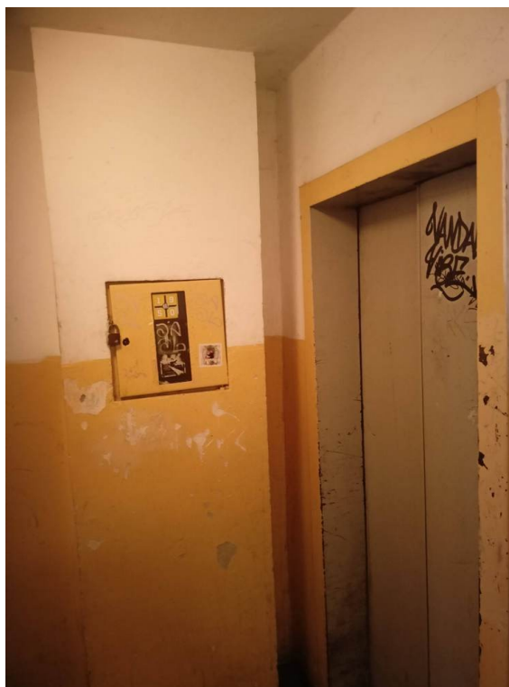
Dojście do windy w poziomie parteru - po lewej stronie widoczna obudowa nieczynnego szachtu instalacyjnego przeznaczona do rozbiórki
