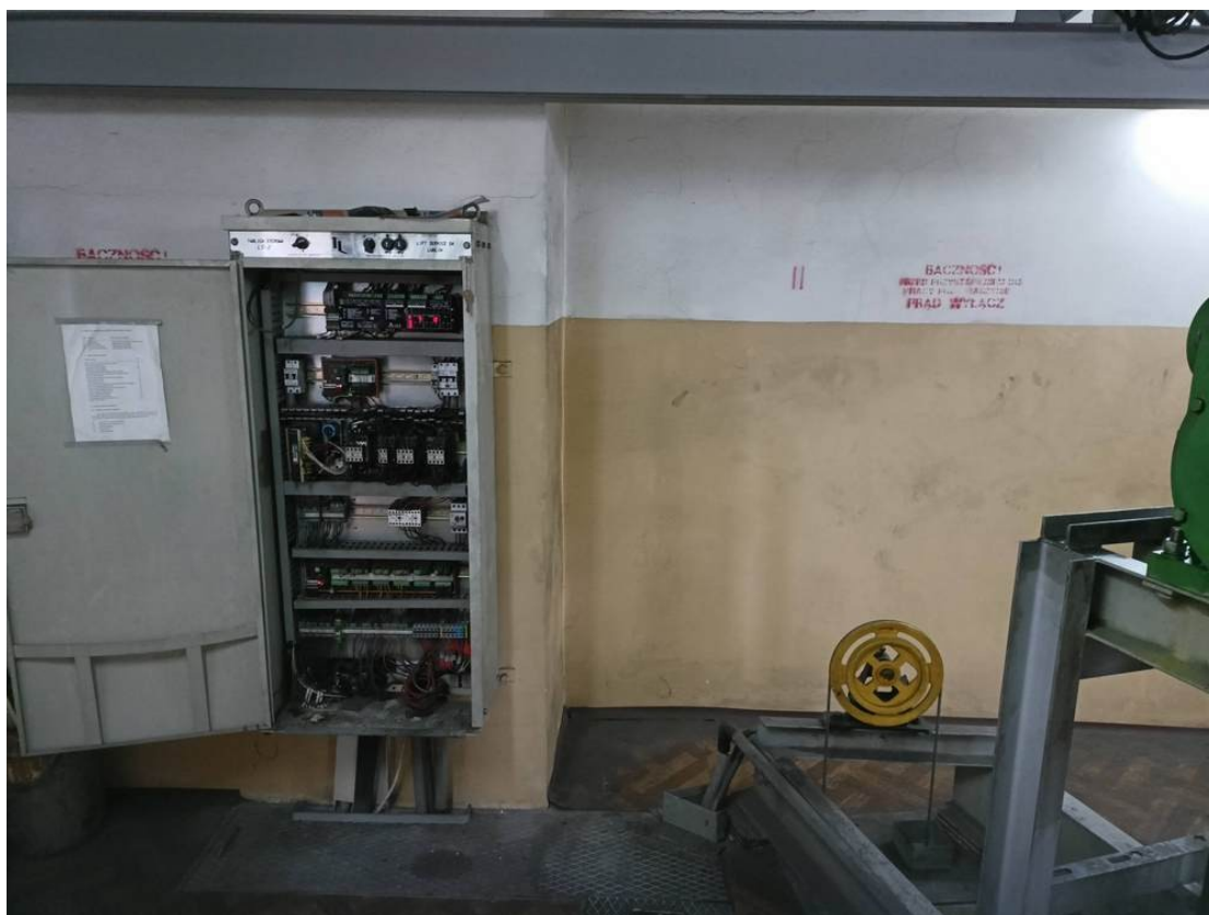
Istniejąca szafa sterowa - proponowana lokalizacja nowej szafy sterowej
