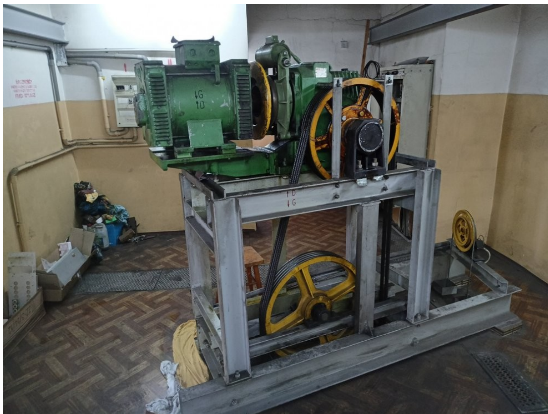
Istniejący zespół napędowy do demontażu
